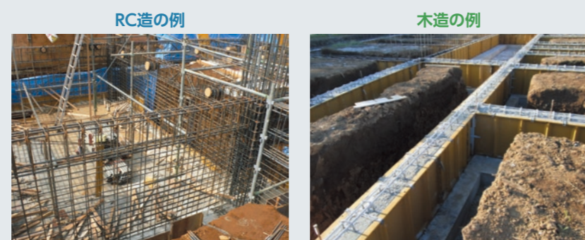
重量が重いRC造と軽い木造とでは、基礎工事の規模、手間、コストなどに大きな差がでる
